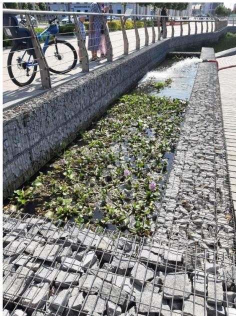
Рисунок 1 - Один из трёх каскадов фито-очистных сооружений (май 2023)
